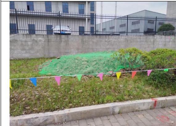
25、塔基开挖临时土石方彩条布覆盖
