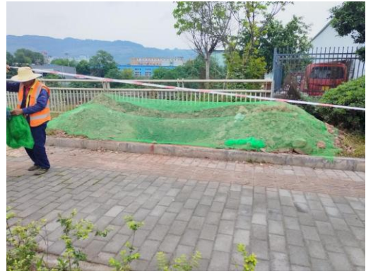
24、塔基开挖临时土石方彩条布覆盖
