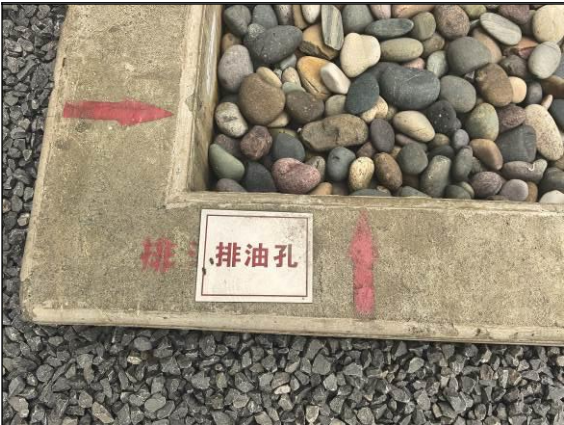
主变下方铺设鹅卵石（无漏油痕迹）
