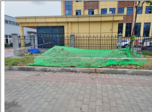
23、塔基开挖临时土石方彩条布覆盖
