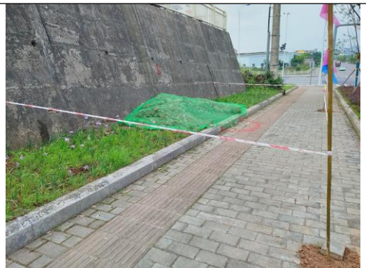
22、塔基开挖临时土石方彩条布覆盖
