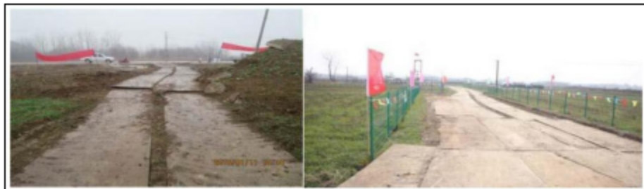
图5-4 临时道路铺设钢板实例示意
