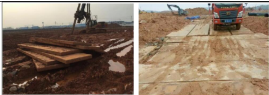
图5-5 临时道路路基箱铺设实例示意
