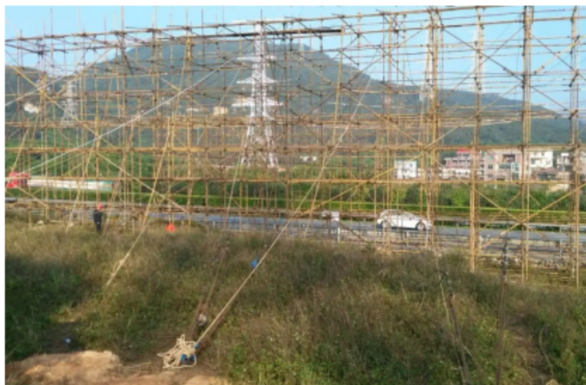
图2-2 输电线路跨越架搭设影像实例
