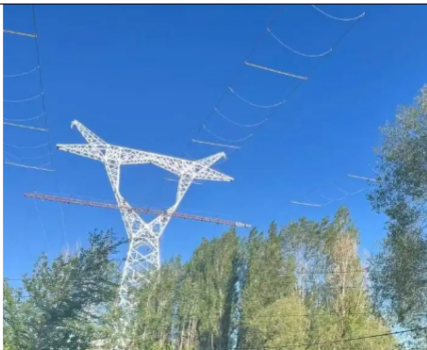
图 2-3 输电线路横担封网搭设影像实例
