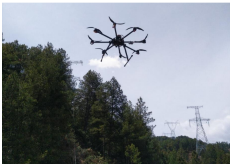
图 2-4 无人机放线施工示例
