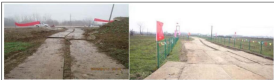
图5-2 临时道路铺设钢板实例示意
