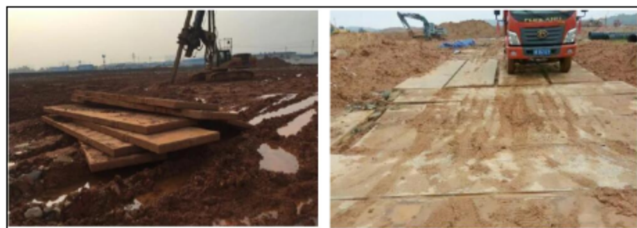
图5-3 临时道路路基箱铺设实例示意
